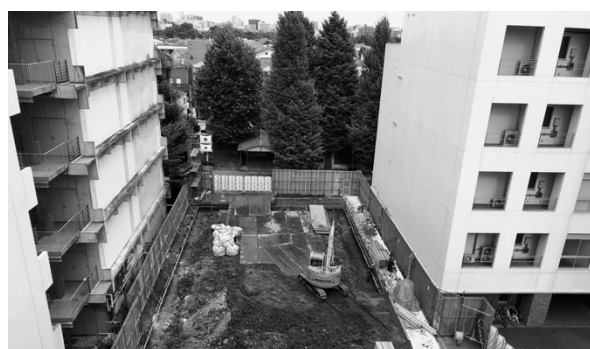
南1号館6階東側から撮影した新サークル棟の建設現場
