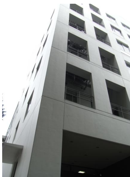
東2号館を見上げる
