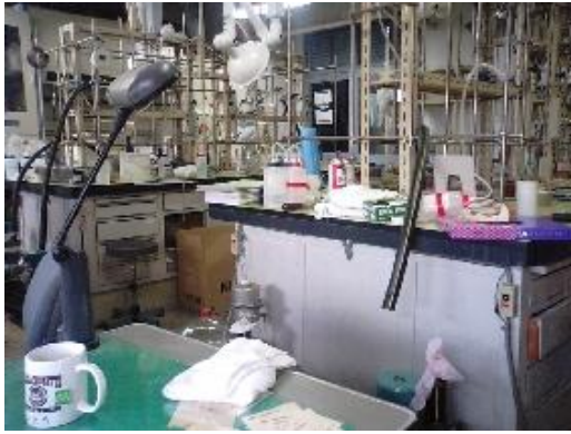
解体されつつある南1号館570号室
