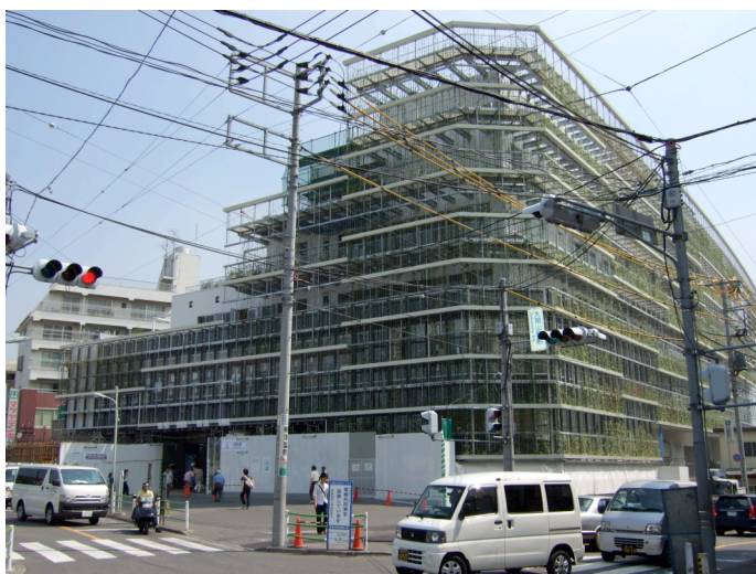
大岡山駅直上の東急病院の建築が急ピッチで進んでいます。
