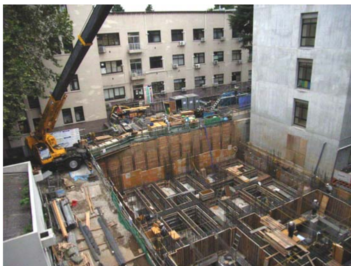
本年度末の竣工に向けて新棟の建設が着々と進行中。 (本館と南1号館の間)
