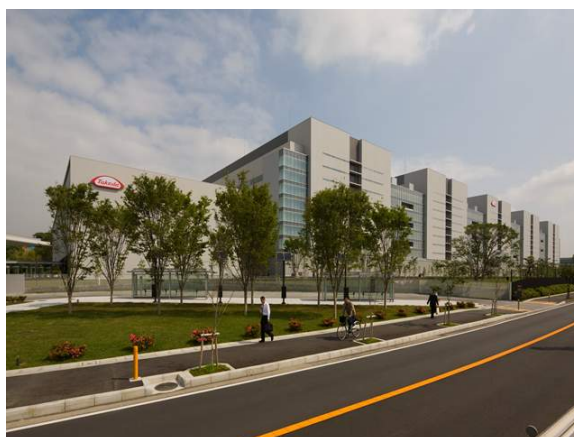
湘南研究所外観（南側）
