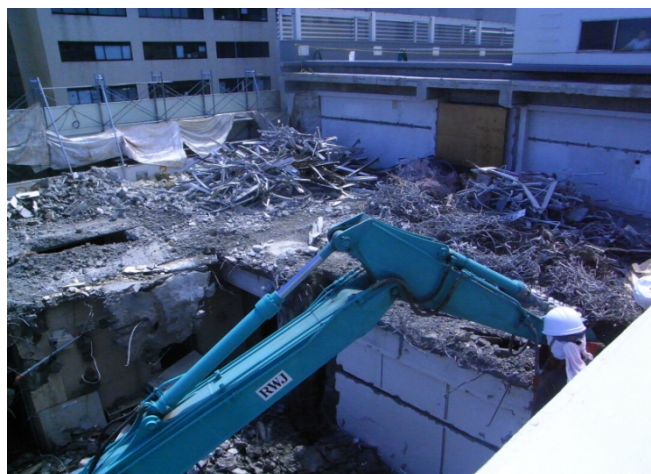
南一号館東側の取り壊しの様子(東2号館より撮影)
