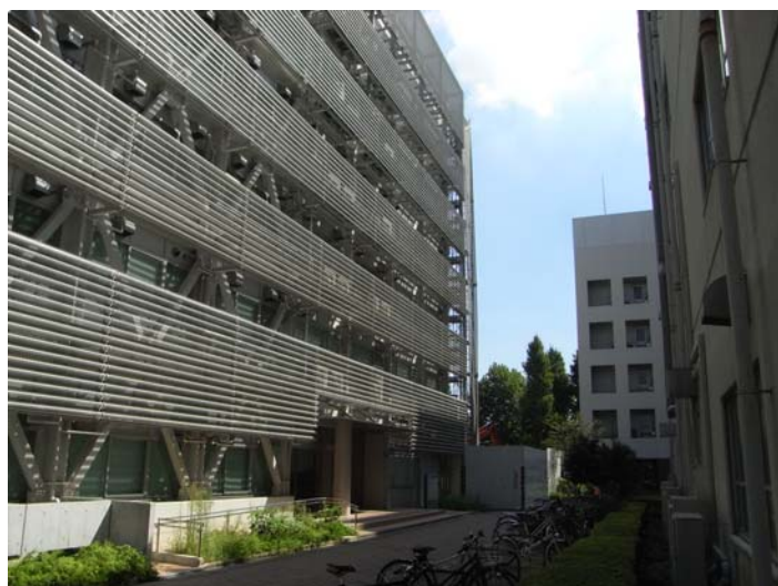
南1号館東半分の解体後（左の建物が南1号館西半分）
