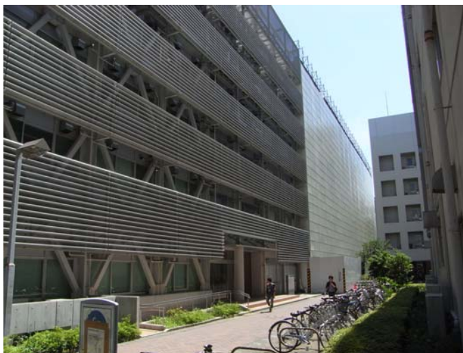
南1号館東半分の解体前（防音壁で覆われています）
