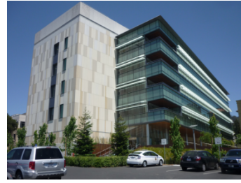
EBI 地下1階、地上5階建て の全フロアでバイオマス変換 に関する研究が行われている。
