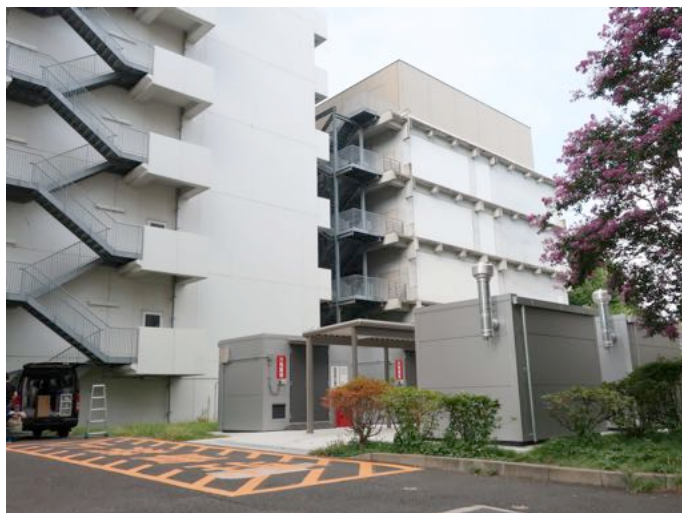
2018年3月に屋外危険物貯蔵庫がプレハブ建築となり、旧南1号館東側部分の跡地（H25桜花会誌表紙下の写真と同じ場所です）へと移設されました。写真左手奥の建物は東2号館、右手は理学院東1号館です。
