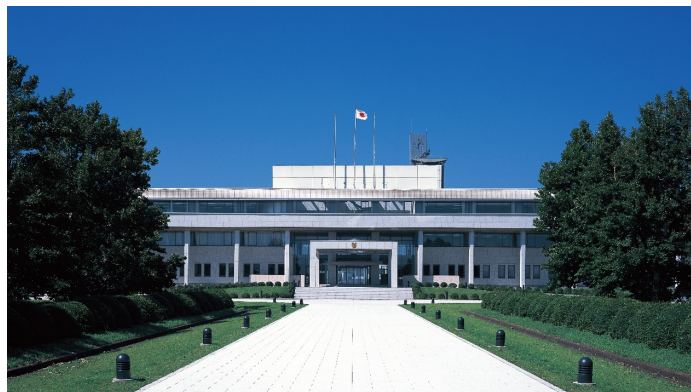
写真 1: 防衛大正門からの写真。中央に写るのは本館。
