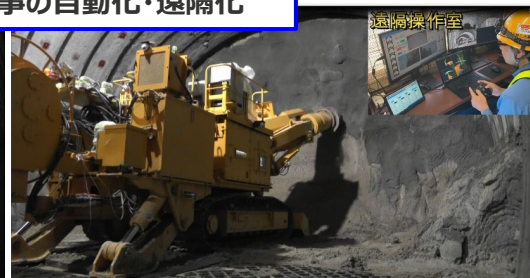
山岳トンネル工事の自動化・遠隔化
